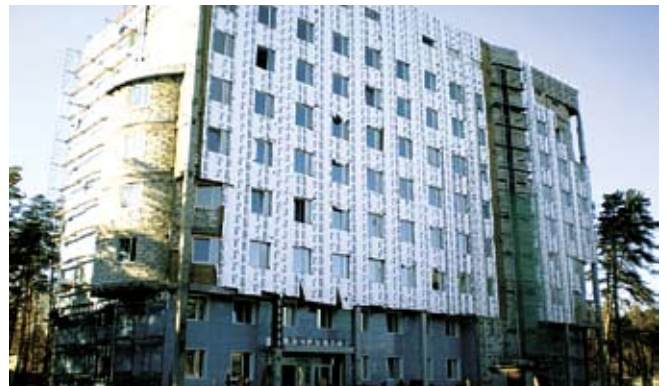
Строительство поликлиники нового онкодиспансера на территории старой ККБ
